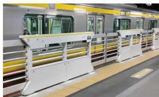
ホームドアの設置
