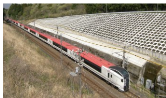
沿線斜面の補強
