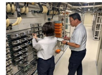
特に力を入れる修繕内容 (左：レール交換 右：信号リレー取替)
