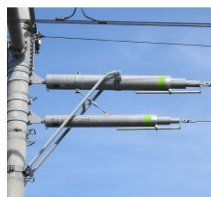
架線設備の更新
