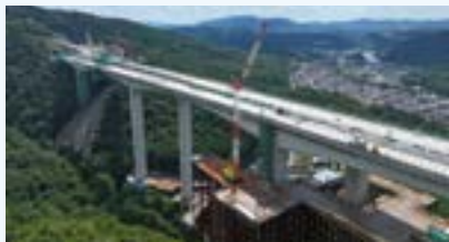
新名神高速道路 信楽川橋 (PC上部工) 工事
