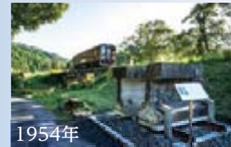
信楽高原鉄道 第一大戸川橋梁 日本初の本格的ポストテンション式PC橋。2021年に国の重要文化財に指定
