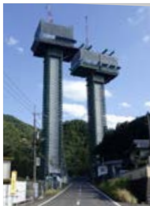
柱頭部ブラケットの大型化
