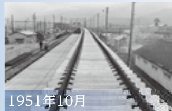
PCマクラギ 国内初となるPC技術の実用化、「PCマクラギ」の量産化を実現
