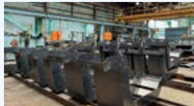
橋桁用鋼製型枠の製作状況
