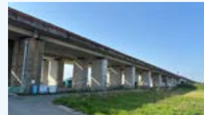
立山〜朝日に間コンクリート構造物補修工事泉高架橋全景
