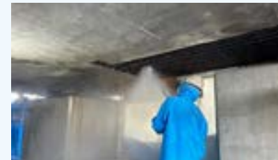
神田高架橋／断面修復工における主桁部はつり施工状況
