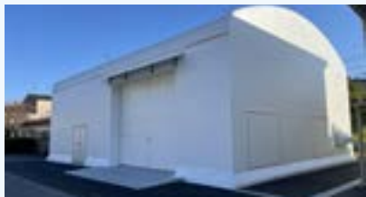
ピーエス・コンストラクション水島工場テント倉庫増築工事
