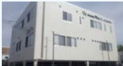
株式会社町おこしエネルギー社屋新築工事
