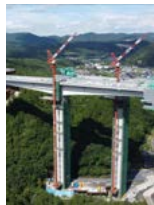
排水管同時施工
