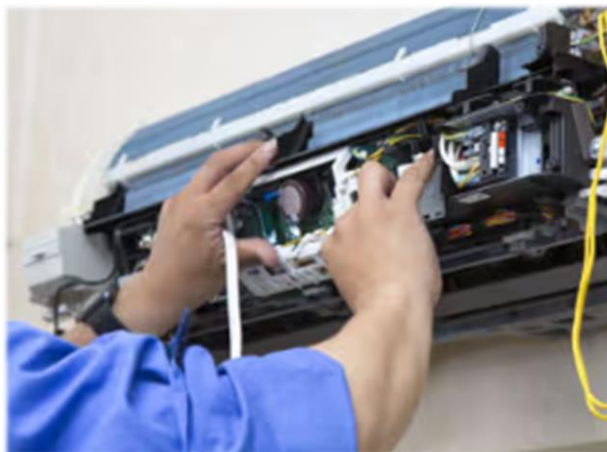
<エアコン取付>
