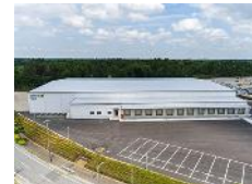
LOGITRESちはらサーチパーク (千葉県千葉市)
