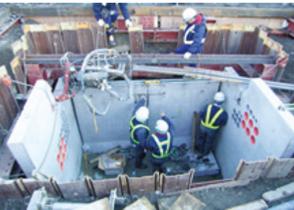
電線共同溝の設置作業
