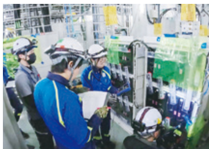
通信キャリア局内でのネットワーク接続作業
