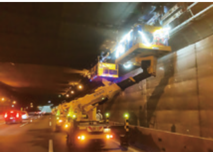
高速道路での照明設置作業
