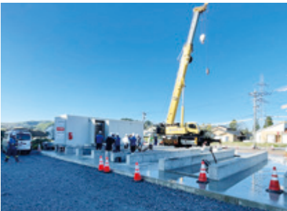
蓄電所構築作業
