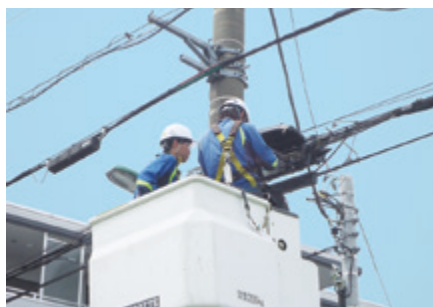
バケット車による高所設備の点検作業
