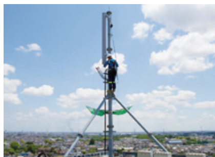
モバイル基地局でのアンテナ設置・ケーブル接続作業
