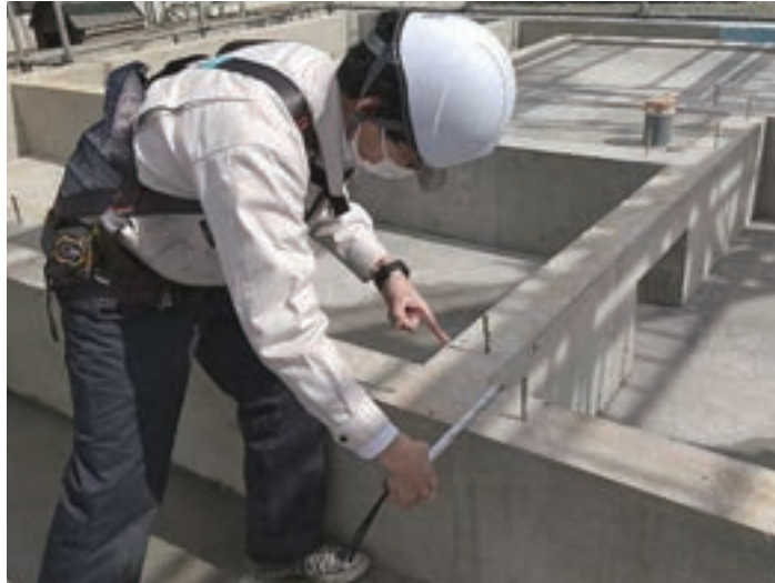
現場での検査の様子
