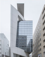
大宮NSDビル
