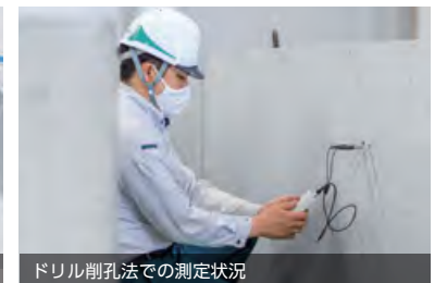
ドリル削孔法での測定状況
