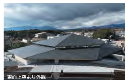
東面上空より外観
