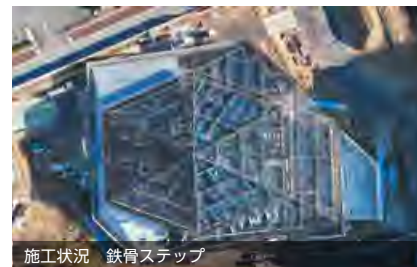
施工状況 鉄骨ステップ
