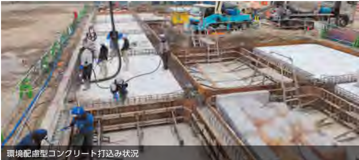
環境配慮型コンクリート打込み状況
