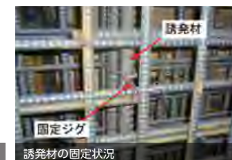
誘発材の固定状況
