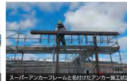
スーパーアンカーフレームと名付けたアンカー施工状況
