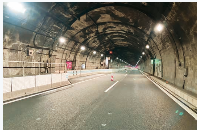
補強工事を完了した一本松トンネル
