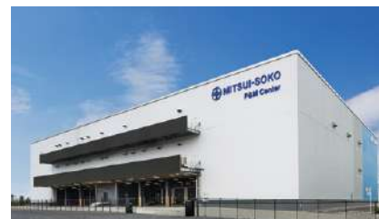
建設イメージ 関東P&Mセンター 既存A棟外観
