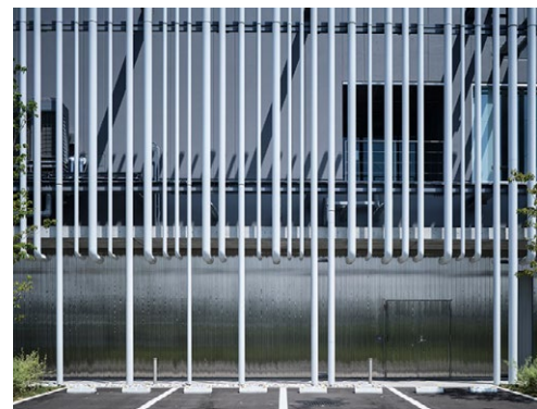
雨どいとして利用しているルーバー
