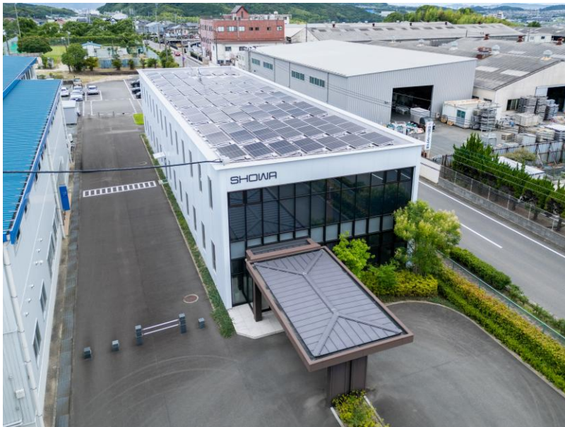
宇美工場（本社棟） 最大出力50kW
