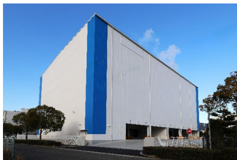
「神戸六甲MT Logi Cold」外観
