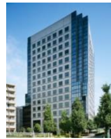
大崎MTビル
