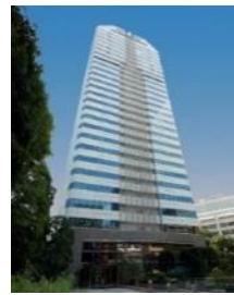
紀尾井町ビル
