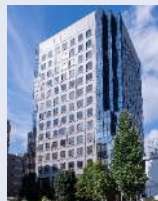
大崎MTビル
