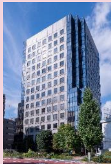
大崎MTビル
