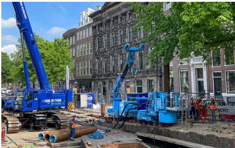
商業化フェーズ第一弾工事の様子
