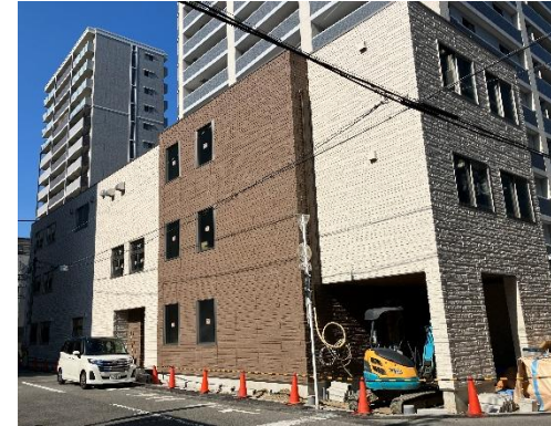
さくらさみらい 東平（現在建設中）
