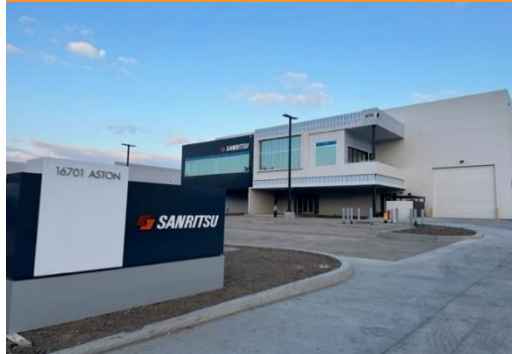
【米国西海岸 新倉庫完成】 2023年10月稼働開始
