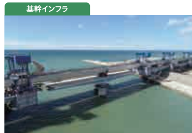
新手指川橋架替プロジェクト 過酷な塩害環境に100年耐える、クラッド鋼を用いた新たな橋梁を架設
