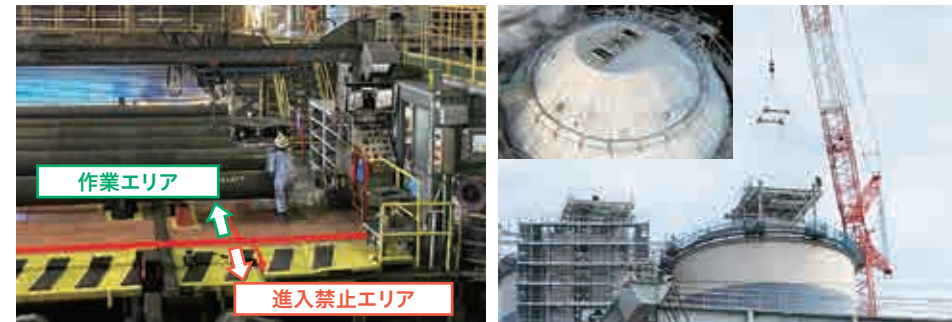
AIカメラが人物を検知すると設備の稼働を自動で停止（JFEスチール）
