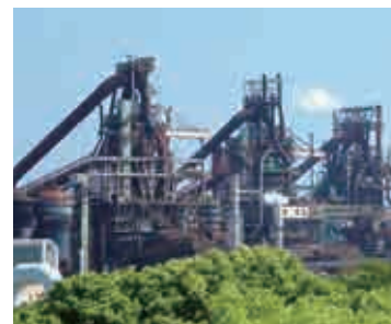
西日本製鉄所（福山地区）の高炉群
