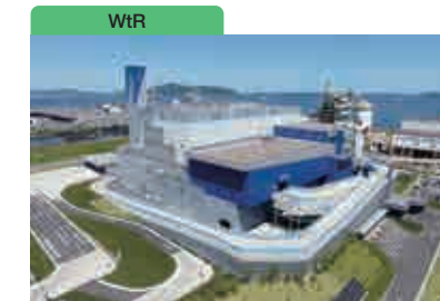
福山ローズエネルギーセンター 福山市内の複数のごみ処理施設を統合し、処理能力は中四国地方で最大級を誇る
