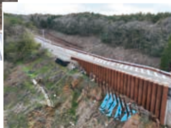
鋼管矢板による応急対策
