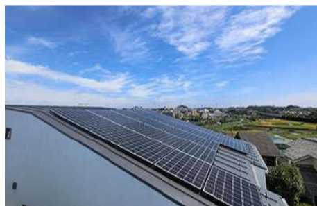
太陽光発電システム
