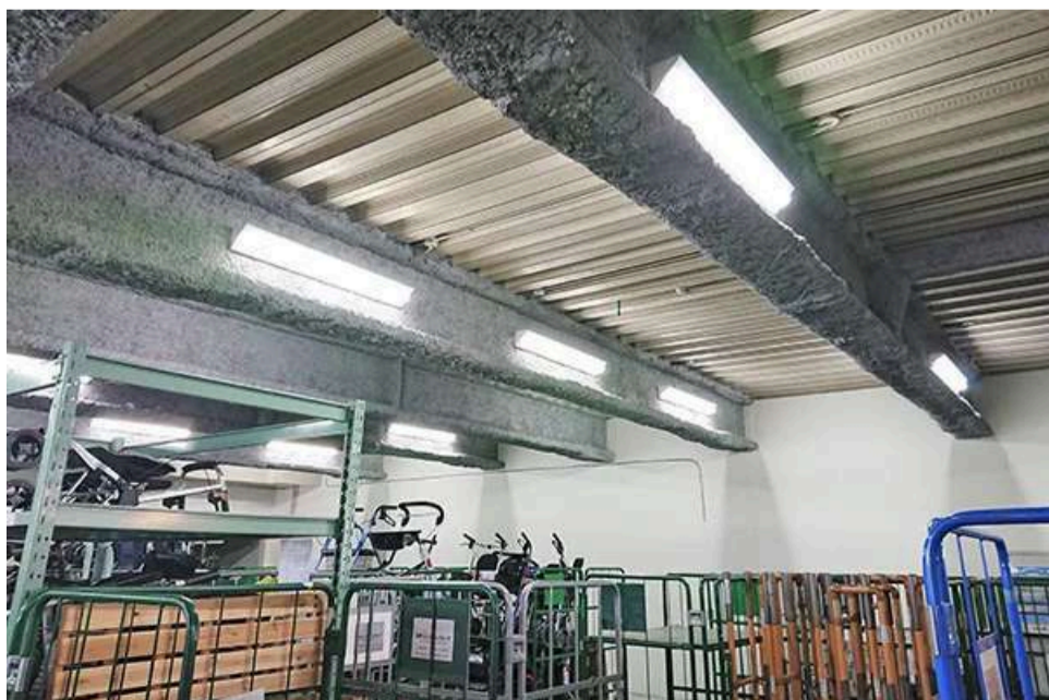
全館LED工事の推進
