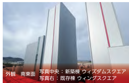
施工中 南東面 写真中央：移動式昇降足場(リフトクライマー)
