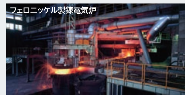
フェロニッケル製錬電気炉 世界最大級の電気炉であり、鉱石等を電気抵抗熱で溶かし、フェロニッケルを製錬します。
