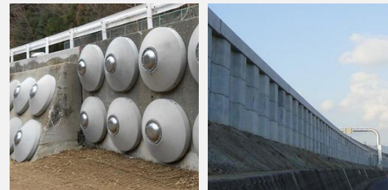
豪雨や地震による土砂崩れを抑制
