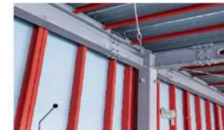
強化セッコウボード(防水・防カビタイプ)12.5mm 以上
