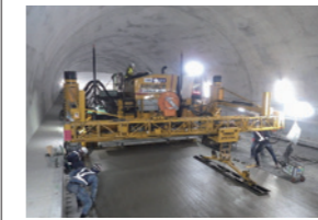
国土交通省大野油坂道路和泉トンネル貝皿地区舗装工事(福井県)
