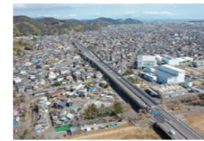
国土交通省令和6年度 島田金谷BP舗装工事(静岡県)
