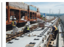
2007年 東北新幹線 青森軌道敷設他
