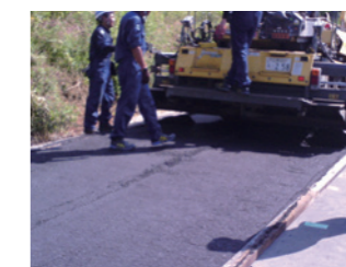
常温アスファルト混合物の舗設状況
