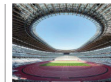
2019年 (写真提供：大成建設株式会社) 国立競技場竣工（陸上トラック基盤）
