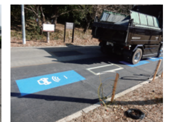
非接触給電舗装
