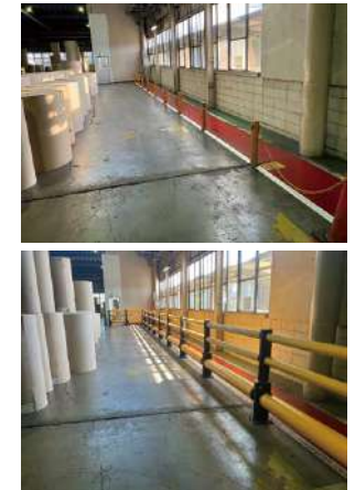
工場構内通路への安全柵の設置 （上：設置前、下：設置後）
