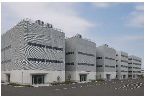
データセンター外観
