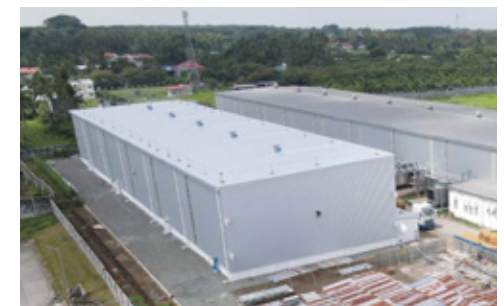
MPST社第2工場を建設中
