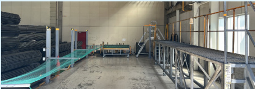
トラック転落防止ネット・作業台の設置(堺工場) 積込時の作業台、転倒・転落防止ネットの設置
