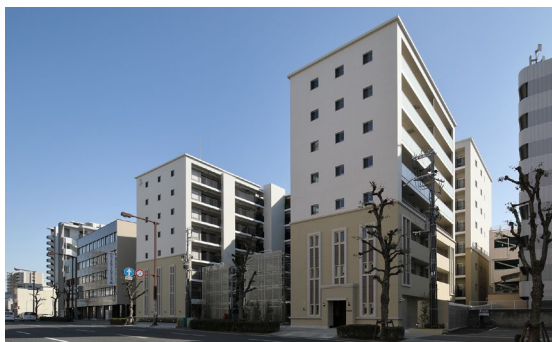
マンション工事
