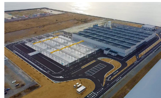
工場施設工事
