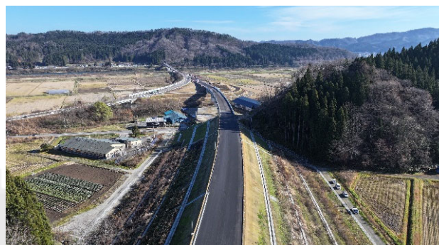
竜毛沢地区改良舗装工事
