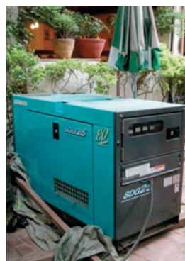
レストラン非常用発電機 設置現場
