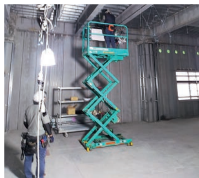
高所作業車 配線・配管作業現場(日本)
