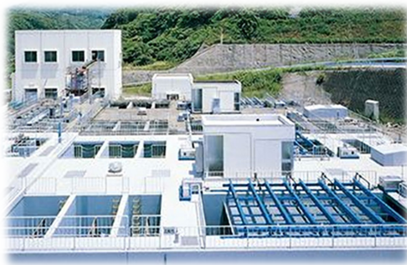
浄水施設(浄水場)の全景
