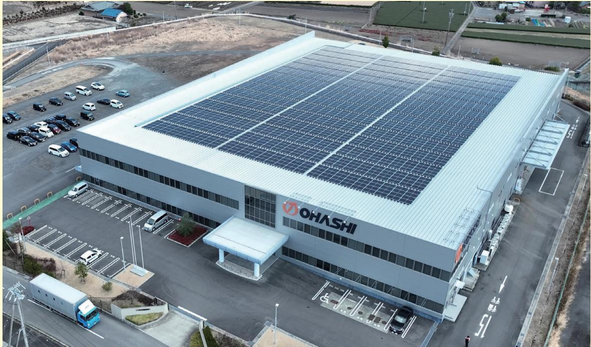
当社は、国内製造子会社「オーハシ技研工業」の鈴鹿工場に太陽光パネルを設置し、2025年4月より稼働を開始いたしました。同発電設備は、太陽光パネル1,620枚から構成され、総パネル面積約3,500平方メートルにのぼります。年間発電量は約56万kwhであり、鈴鹿工場の使用電力の約30%をまかない、CO2排出量は年間約257トン削減される見込みです。
