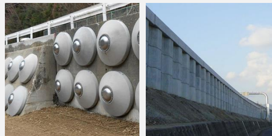
豪雨や地震による土砂崩れを抑制
