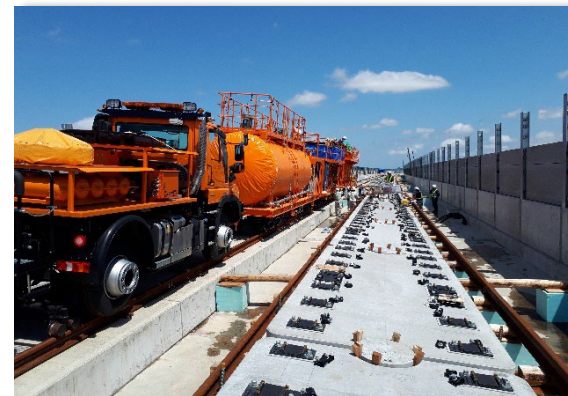
北陸新幹線 福井軌道敷設他工事
