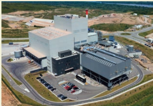
(セルビア・ベオグラード廃棄物処理発電所)
