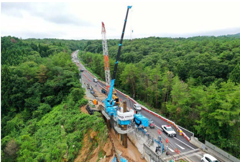
「のと里山海道」での土留め壁構築工事の様子
