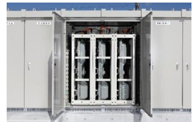
EV 使用済みリユースバッテリーを活用 した環境配慮型「産業用太陽光自家消費 蓄電池システム サファ Link -ONE-」
