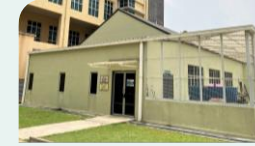
熱帯バイオマス技術研究所 @マレーシア
