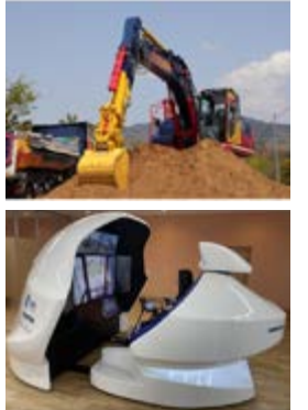
遠隔操作仕様車の油圧ショベル(上)と遠隔操作用コックピット(下)
