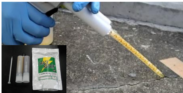
CRACK REPAIR (クラックリペア)
