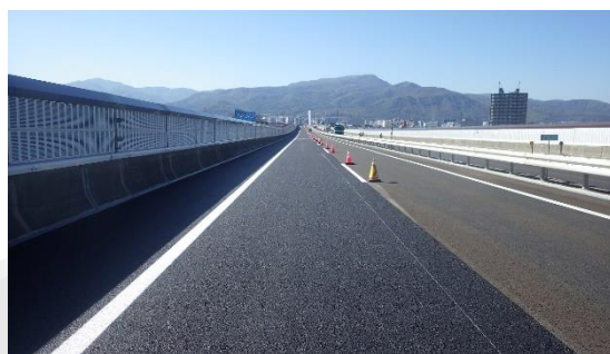
札幌自動車道発寒高架橋 床版防水工事
