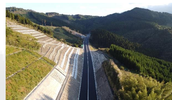
東九州道(清武～北郷) 赤木地区外舗装工事
