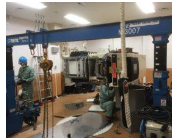
【屋内での重量物撤去作業】
