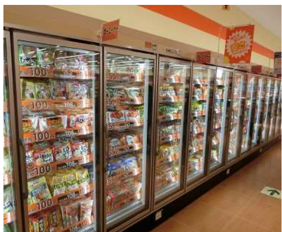
冷蔵・冷凍ケース更新
