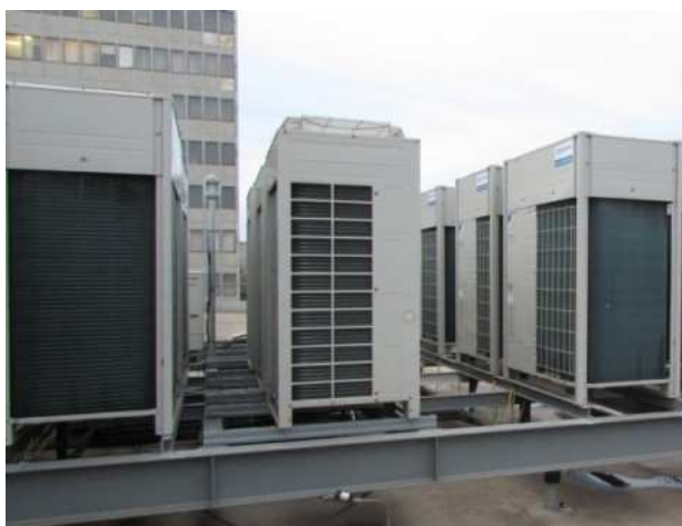
空調室外機フィン清掃
