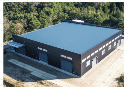
▲ 2022年12月現在 建屋完成
