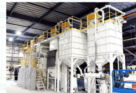
▲ 設備搬入状況の一例
