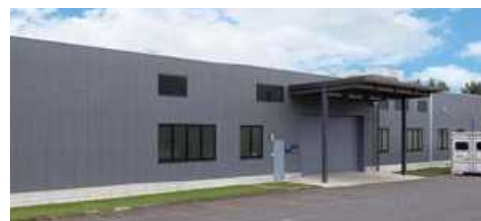
バッテリー安全認証センター
