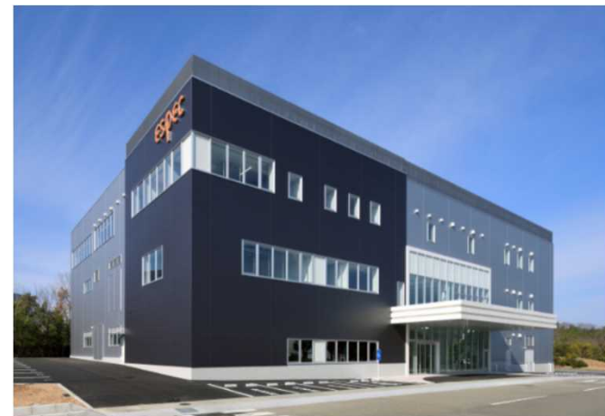
技術開発棟の外観
