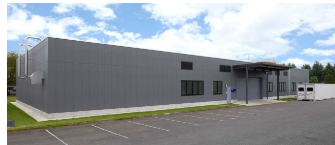
バッテリー安全認証センター
