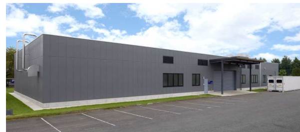
【バッテリー安全認証センター】
