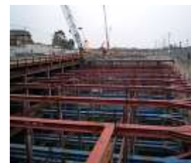
各種仮設解体工事
