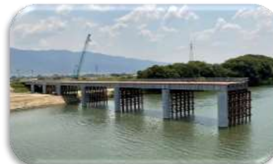
総延長160m：両築橋工事用栈橋（福岡県）
