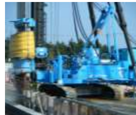
ソイルセメント柱列式連続壁工法
