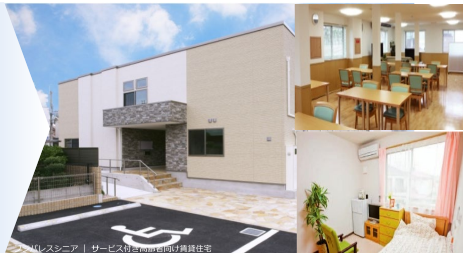
サービス付き高齢者向け賃貸住宅
