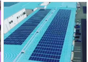
リユースパネルを用いた発電設備
