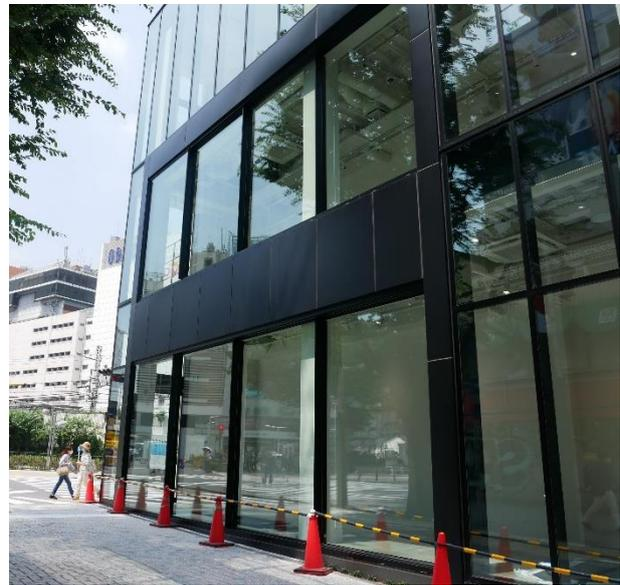
超大型大開口サッシ「GLAMO」は、高さ 3,030mm×幅 8,076mm の3枚引き戸の仕様で、「クロス新宿ビル」の新宿通りから靖国通りへ抜ける道路面、地上1・2階部分に採用されました。
