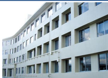
耐震補強工事
