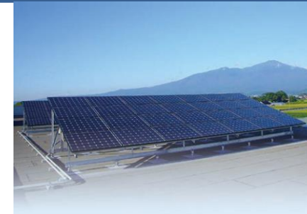
太陽光発電システム設置
