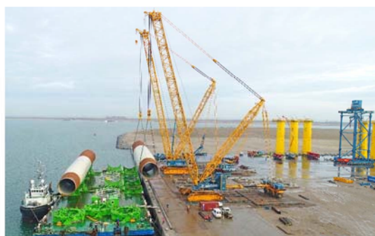
港湾で風車の部材積込を行うクローラークレーン
